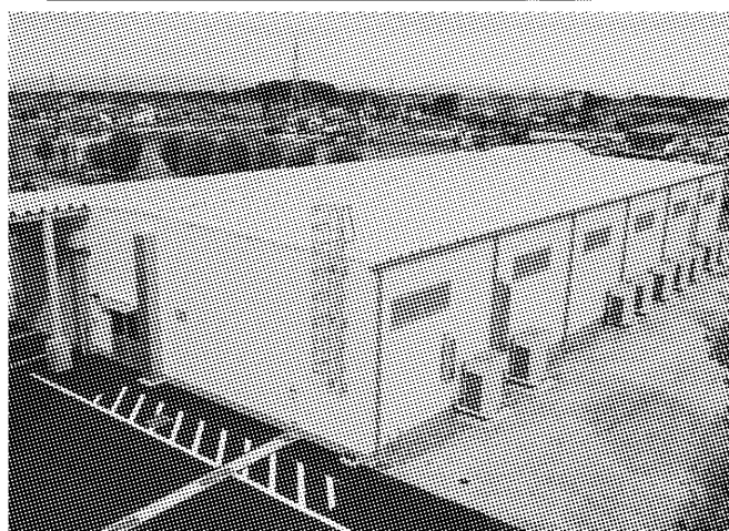
埼玉工場の新工場棟「A棟」。中長期の自動化需要増を見込み直動機器を増産する
