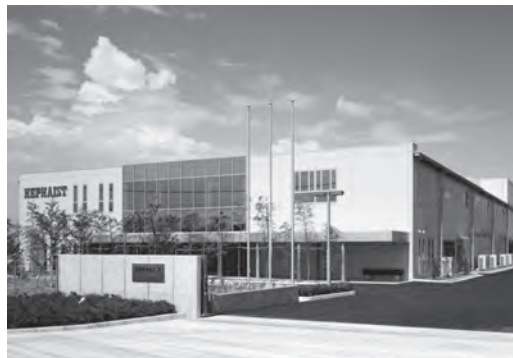
写真2 埼玉県川越市にあるヒーハイスト精工本社工場の外観
